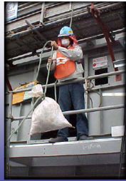
ใช้เชือกผูกมัดวัสดุ อุปกรณ์ เพื่อนำขึ้นบนที่สูง
